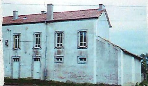
Vue du bâtiment qui abritait l'école et la mairie dans l'ancien village
