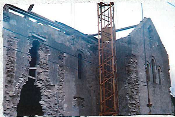
L'église en cours de démolition
